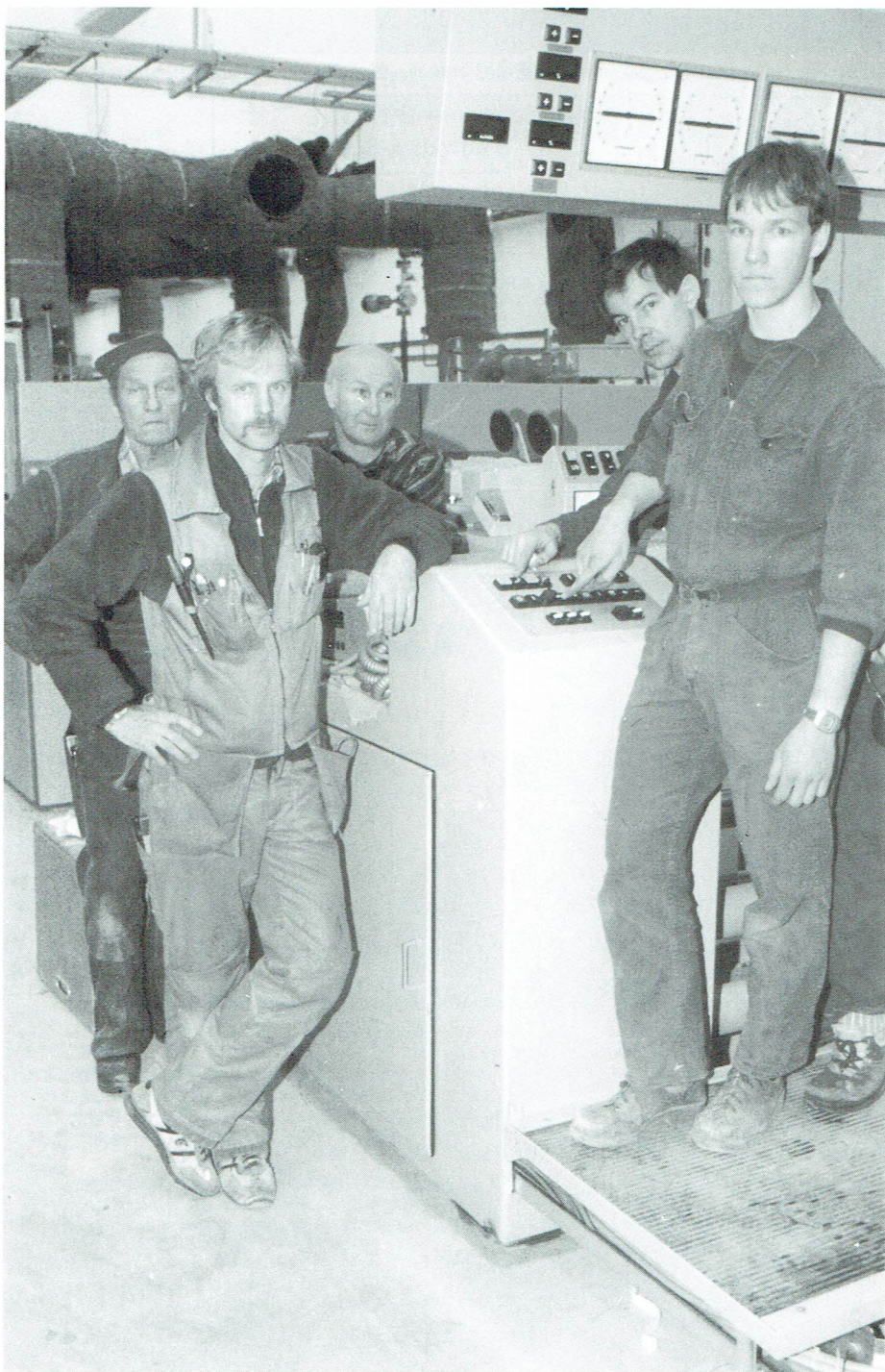
Kalle Sandell, Bertil Karlsson, vår tyska tekniker Horst Grund, Andrej Polewski och Per Oskarsson är i full fär med att installera den nya spannråmen.
