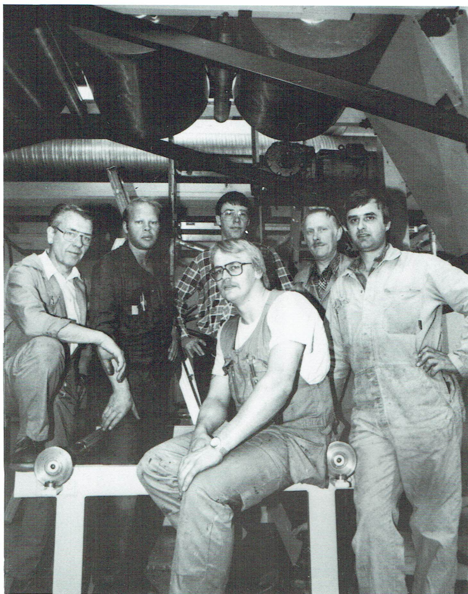
Kjell Svärd, Ingvar Johnsson, Kjell Johnsson, Rune Hansson, Jon Traila och Jörgen Wilhelmsson jobbar febrilt med att montera den första tapetmaskinen i fabriken. Tillverkningen sker internt på den egna verkstaden i Novalin-fabriken.
